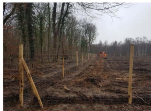
Un grillage a été installé tout autour de la parcelle située en forêt domaniale de Saint-Germain-en-Laye, pour, entre autres, préserver les futurs plants de l'appétit du gibier. Philippe ROUDEILLAT
